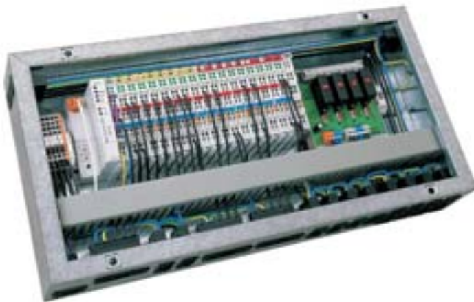
Bild1 Ein TOPLON -Knoten im Verteiler
